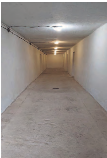
Budynek łazienki obozowej (u góry: stan przed remontem, u dołu: stan po remoncie)
