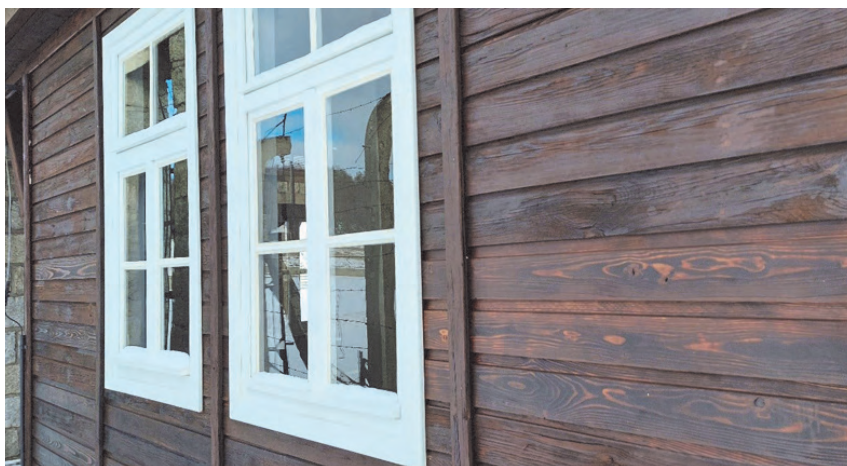
Budynek bramy głównej (u góry: stan przed remontem, u dołu: stan po remoncie)
