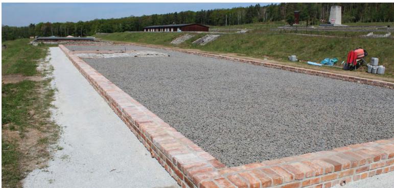
Fot. 6-8. Muzeum Gross-Rosen w Rogoźnicy – konserwacja i rekonstrukcja zachowanych elementów baraków Rewiru I i II
