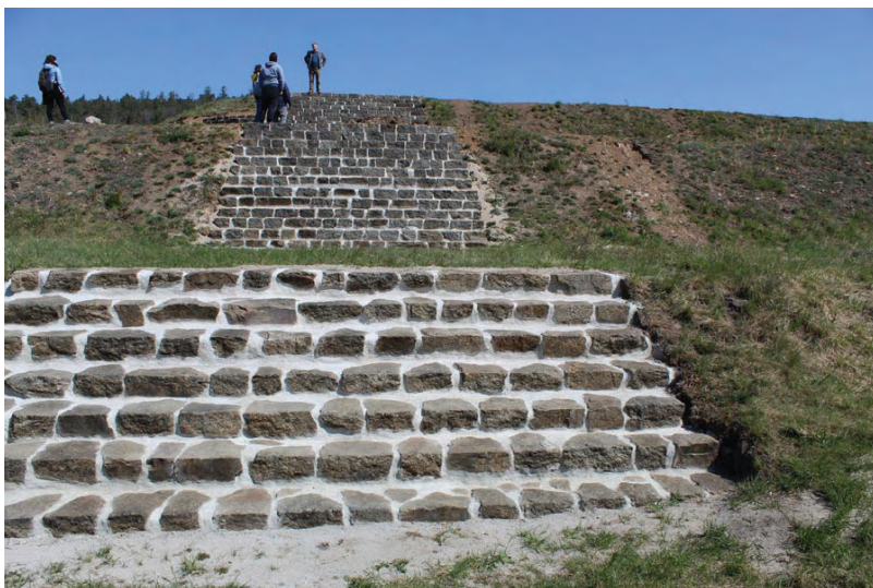
Fot. 9-10. Muzeum Gross-Rosen w Rogoźnicy – remont trzech biegów kamiennych schodów do baraku Rewiru V oraz muru oporowego
