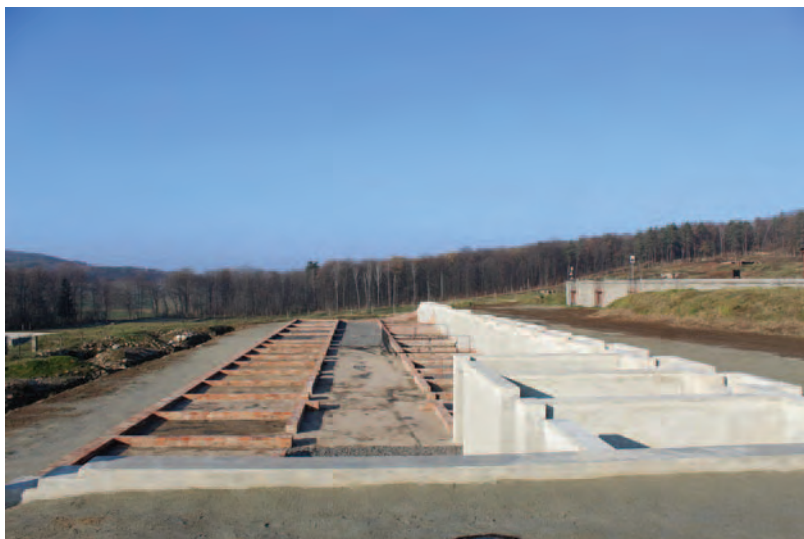
Fot. 11-12. Muzeum Gross-Rosen w Rogoźnicy – remont i konserwacja destruktu baraku nr 11 „Zellenbau”
