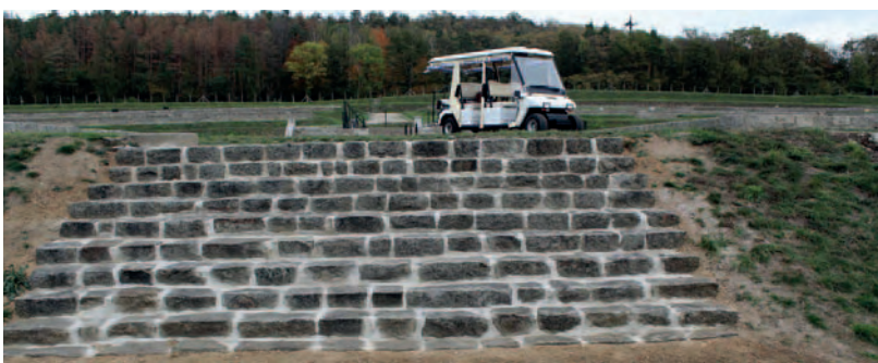
Fot. . 21-23. Kamienne schody gruntowe na terenie Muzeum w Rogoźnicy po przeprowadzonych w 2019 roku pracach konserwatorsko-remontowych
