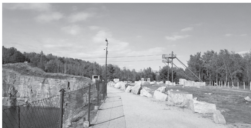
Fot. 18-19. Zakończenie prac konserwatorsko-remontowych przy historycznych wieżach wyciągowych w kamieniołomie, Muzeum Gross-Rosen w Rogoźnicy – wrzesień 2018 r.
