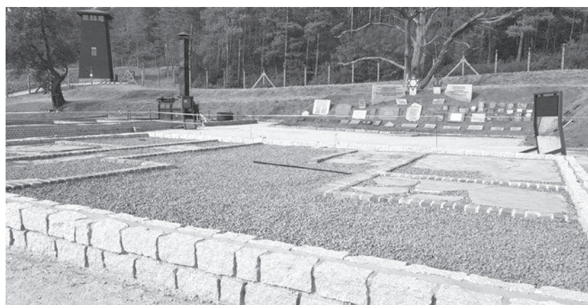
Fot. 20-21. Zakończenie prac konserwatorsko-budowlanych przy pozostałościach poobozowej kostnicy, Muzeum Gross-Rosen w Rogoźnicy – wrzesień 2018 r.
