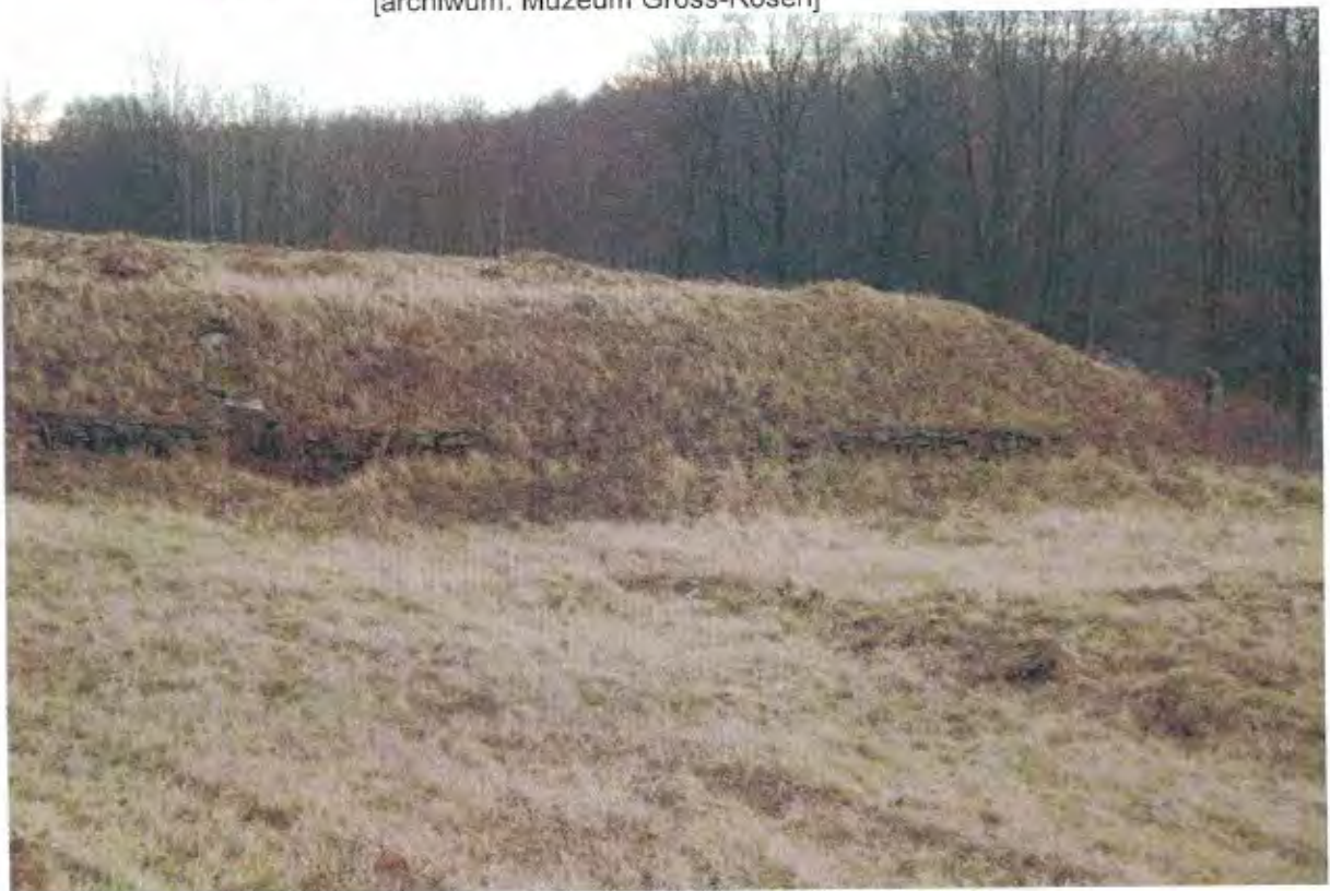
Fot. 2. Widoczne fragmenty muru północno - zachodniego. [autor: Daria Sułek-Chlebowska – CCI sp. z o.o.]
