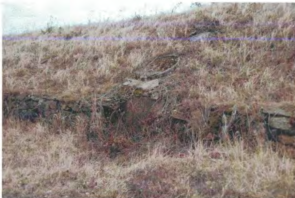
Fot. 3. Widoczne fragmenty muru oraz studzienek - strona północno - zachodnia. [autor: Daria Sulek-Chlebowska – CCI sp. z o.o.]
